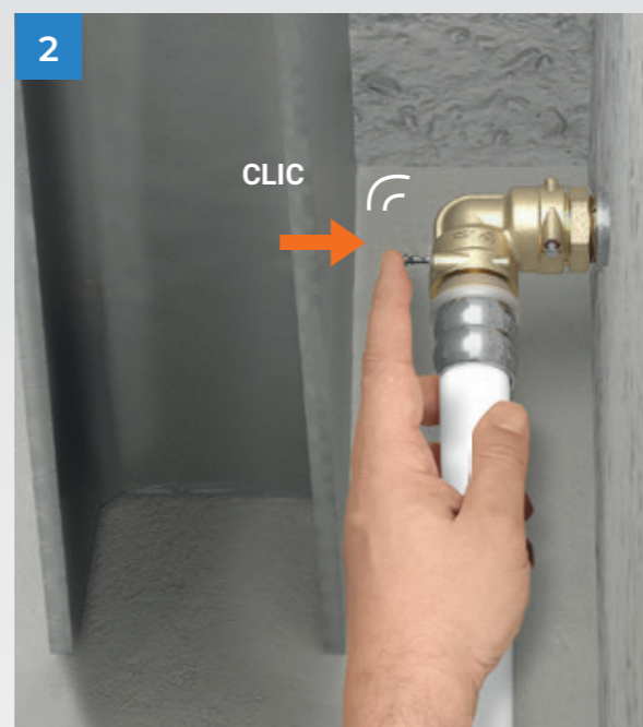
2 La fixation est scellée par un CLIC L'embout ne peut être abaissé que si le raccord a été correctement inséré.
